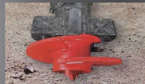
打設用アタッチメントに先端セット
